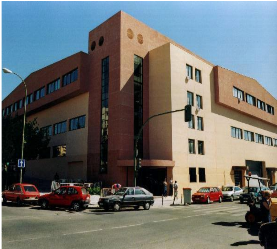
Vista General del Edificio Interxion donde se halla ubicado el IDC de AXARnet Comunicaciones
